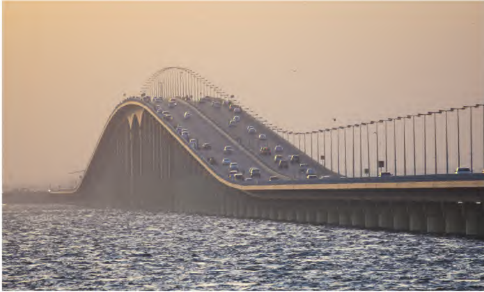
قطاع الإنشاءات البحري فاز بـ 162 مناقصة
